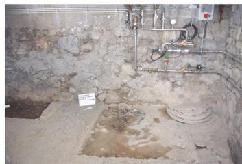
Freigelegter Romazementestrich mit Resten der ursprünglichen Beleuchtungseinrichtung
